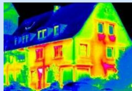
Funeste isolatie-lekken (infrarood-warmte-detectie)
